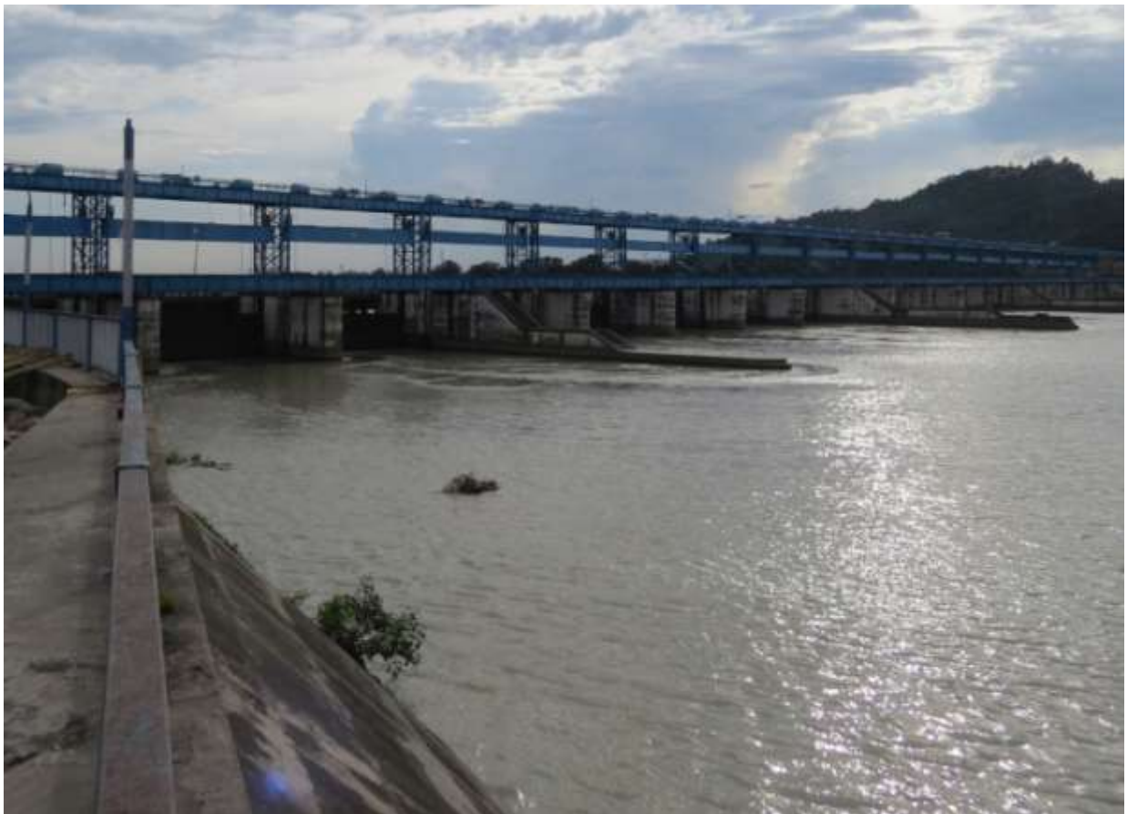
Pic 177 : Bhimgoda Barrage
